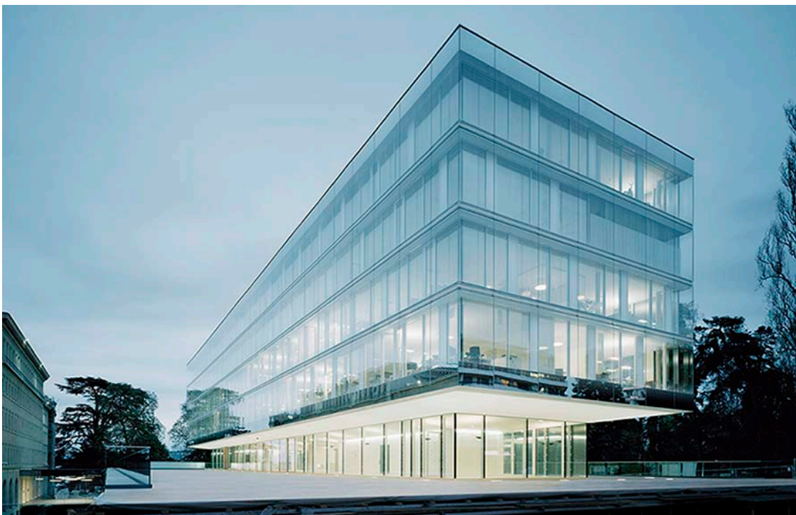
Edificio de la WTO (fuente: WTO)
